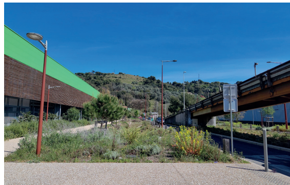
Secteur lingostière à Nice - noue d'infiltration à proximité d'une voirie @AUA
