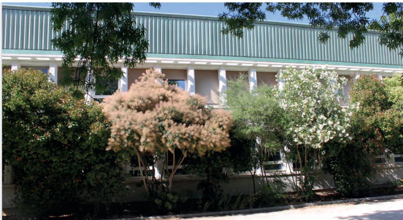
Haie de végétaux ayant une fonction rafraichissante et d'ombrage pour les bureaux. Les essences se sont adaptées, sans arrosage, à un climat sec et chaud - Crédits INRAE
